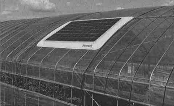
熊本県で実証試験中の太陽電池屋根設置型ビニールハウス(ユニバーサリー電工提供)
